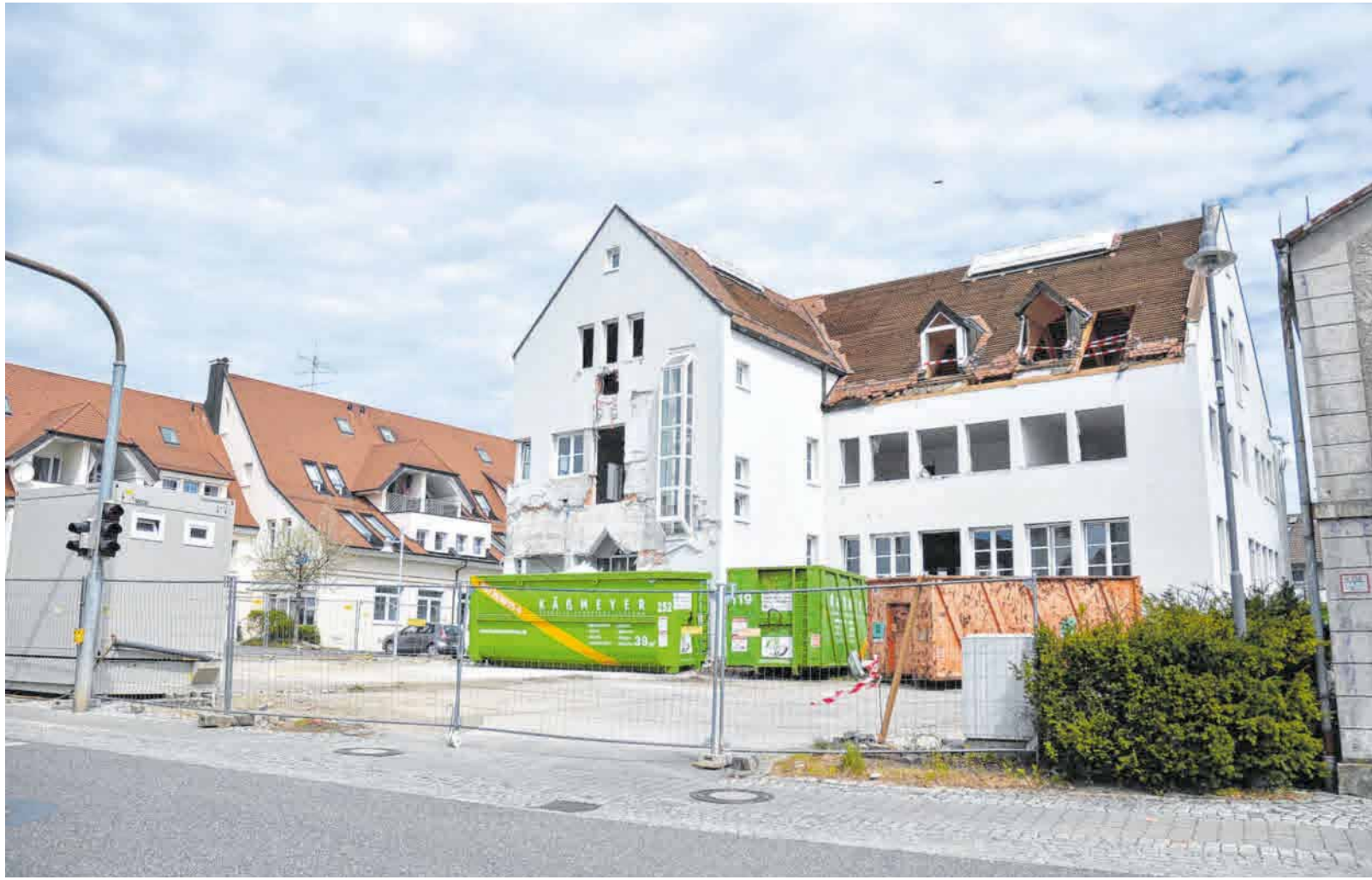
Das Gebäude aus den 1960er-Jahren wird derzeit entkernt und abgerissen. Laut Zeitplan soll es im Sommer mit dem Neubau losgehen.
