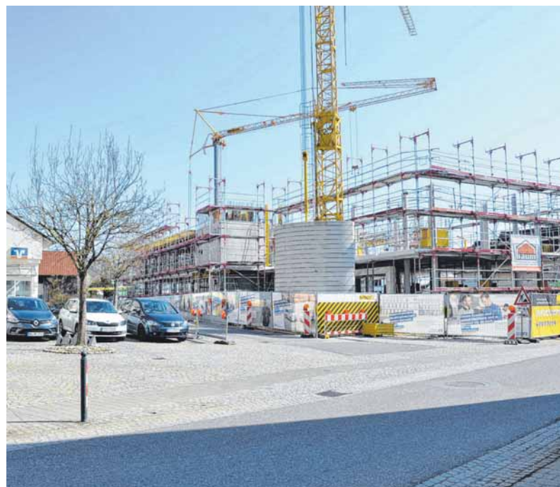
Bei der Gestaltung des Außengeländes soll auch der Bereich bis zur Bäckerei und der Interimsfiliale einbezogen werden. FOTO: JULIA FREYDA
